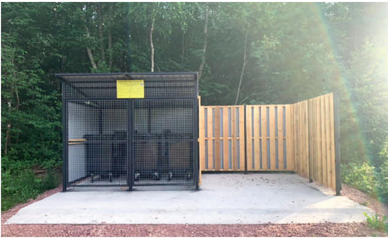
Площадка накопления твердых бытовых отходов в Важинском городском поселении
