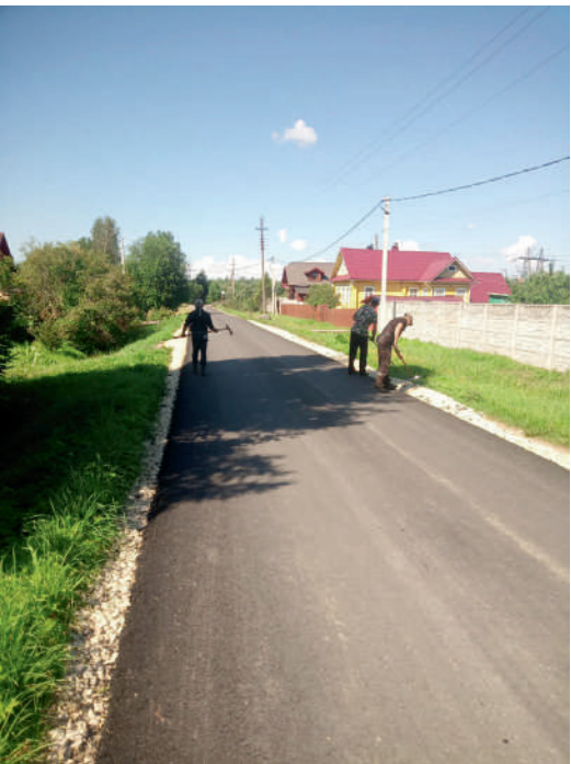
В деревне Назия граждане приняли трудовое участие в ремонте дороги
