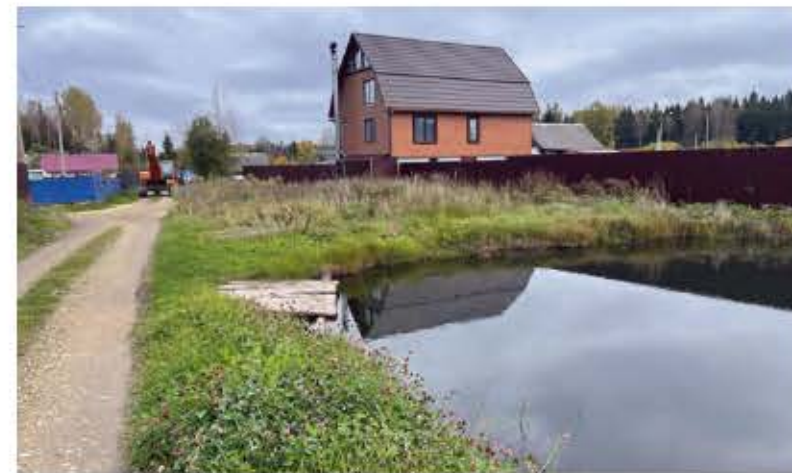
Очистка пожарных водоемов в поселке Стровинье Тосненского района
