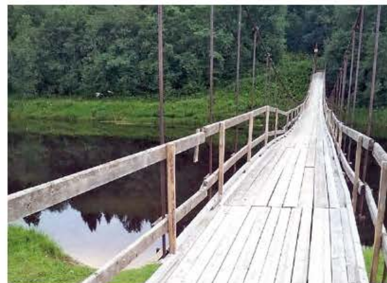
Отремонтированный подвесной мост через реку Оять, Подпорожский район
