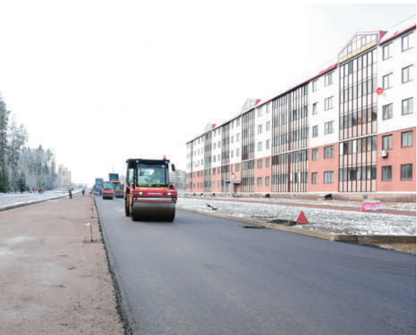
↑ Строительство участка дороги на продолжении ул. Солнечной в районе ЖК «Солнце», Сосновый Бор
