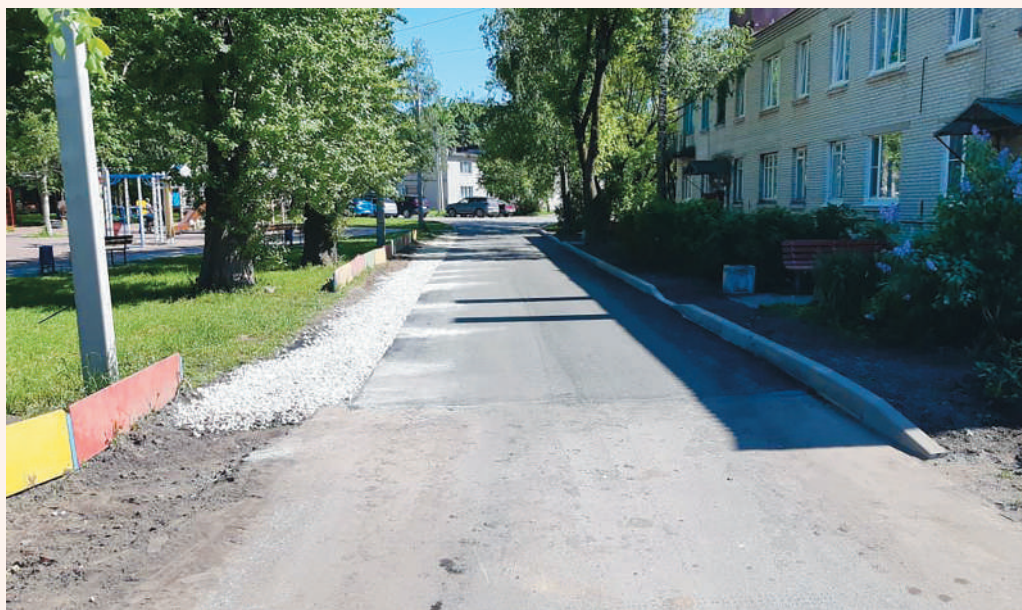
Ремонт дороги в деревне Рабицы
