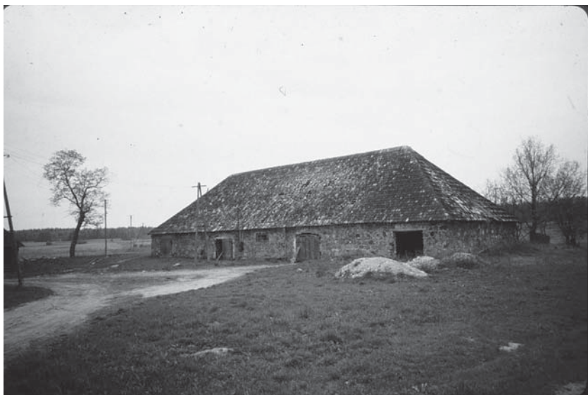
Рис. 4. Каменных хлев, в стены которого были замурованы осколки Иванова камня. Фото Х. Валка. 1996 г.
