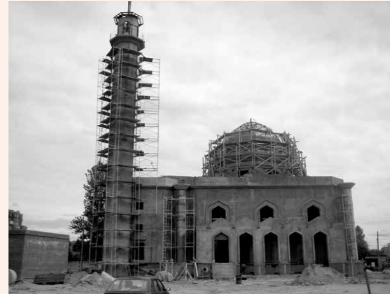
Мечеть в ходе строительных работ
