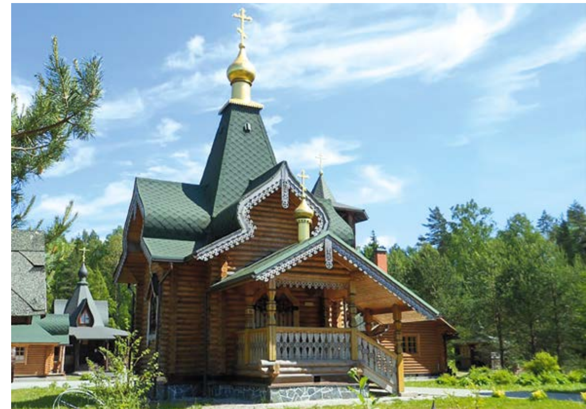
Церковь святых преподобных Зосимы и Савватия Соловецких во скиту святого апостола Андрея Первозванного на «Дороге смерти», Всеволожский район
