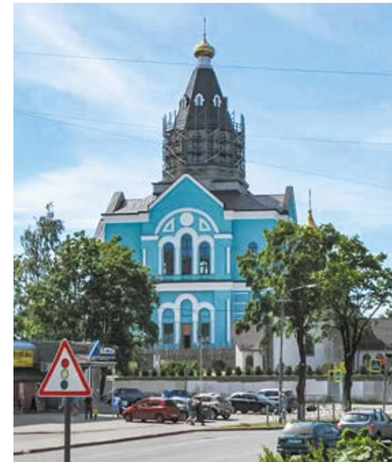
Строящаяся церковь Успения Пресвятой Богородицы в Южном микрорайоне Выборга
