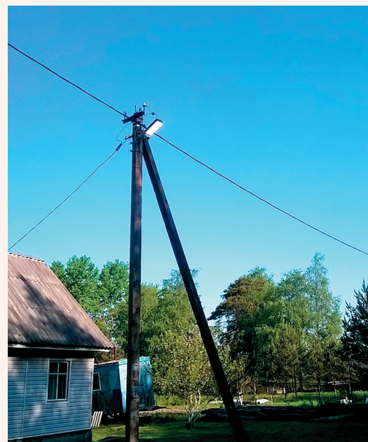
▲ Установка дополнительных светильников
