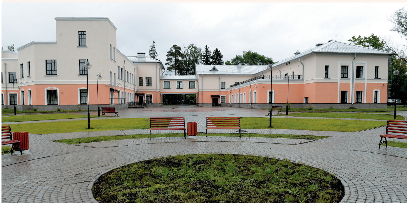
▲ Волосовская школа искусств имени Н. Рериха после реконструкции
