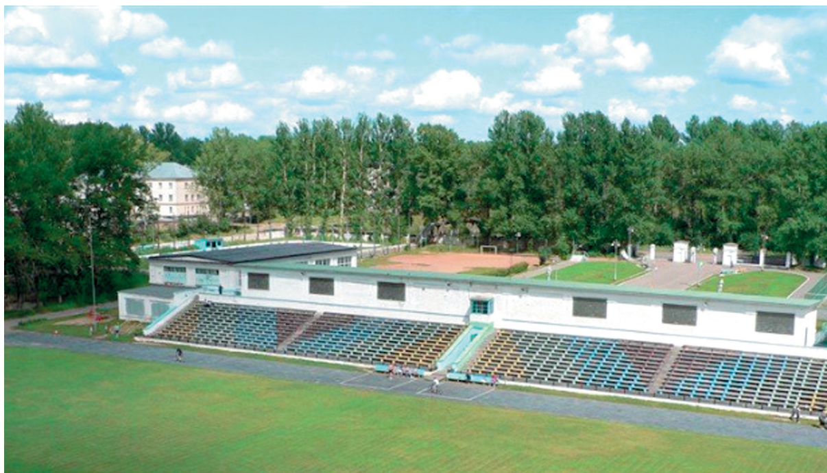
▲ Стадион в Бокситогорске после капитального ремонта
