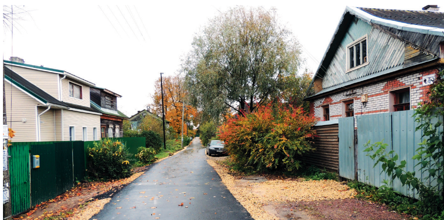
Гатчина. Ремонт дороги
